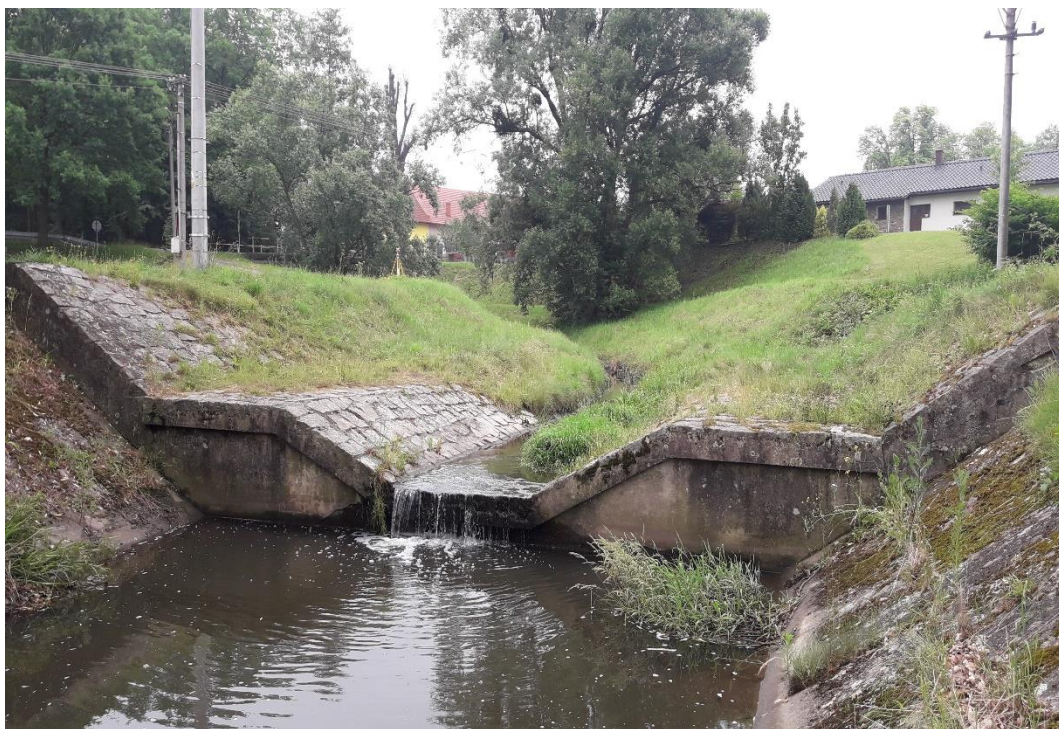
Foto 6 Stabilizační stupeň v km 5,933
